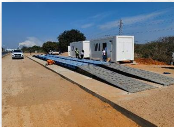
Figura 8 – Construção da Báscula de Mudissa / Figure 8 – Mudissa Weighbridge construction
