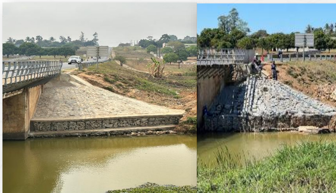
Figura 17 – Reparação de erosão no talude do encontro da ponte sobre o rio Tembwe / Figure 17 –Repair of erosion on the slope of the bridge abutment over the Tembwe River
