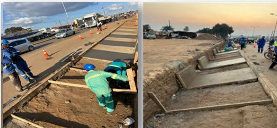
Figura 18 – Construção de um sistema misto de drenagem, no Km 87 (Chimoio) / Figure 18 –Construction of a mixed drainage system at Km 87 (Chimoio)
