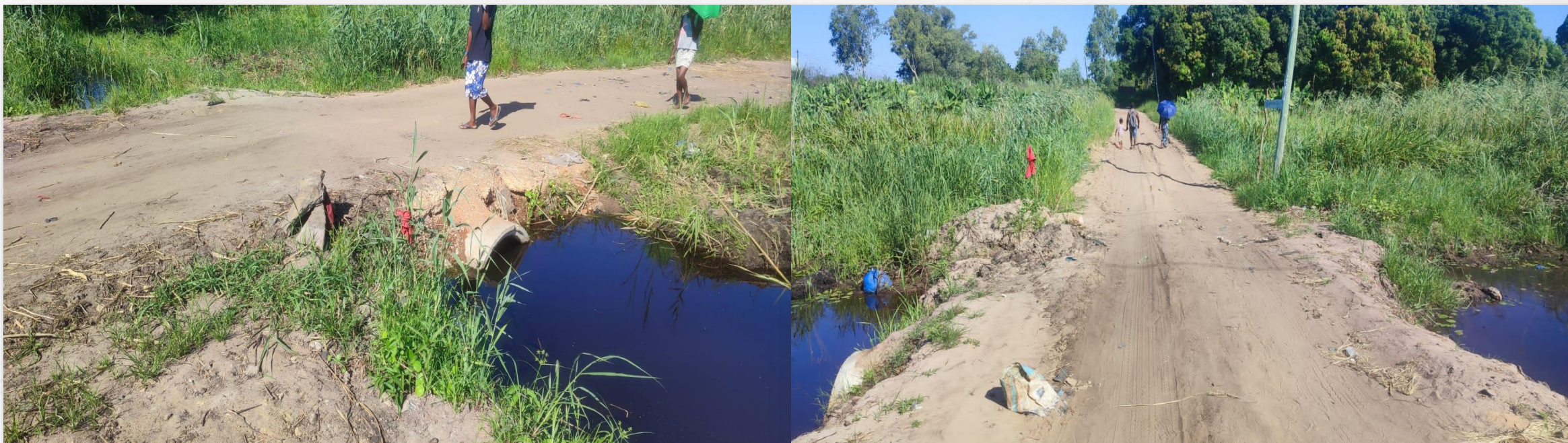
Figura 12 – Construção de Colector de Drenagem na Portagem de Cumbeza / Figure 12 – Construction of Drainage Collector at Cumbeza Toll Gate
