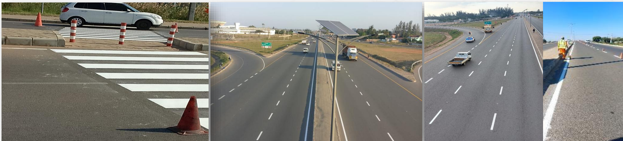
Figura 16 – Sinalização Horizontal na Estrada Circular / Figure 16 –Horizontal Signalling on the Circular Road
