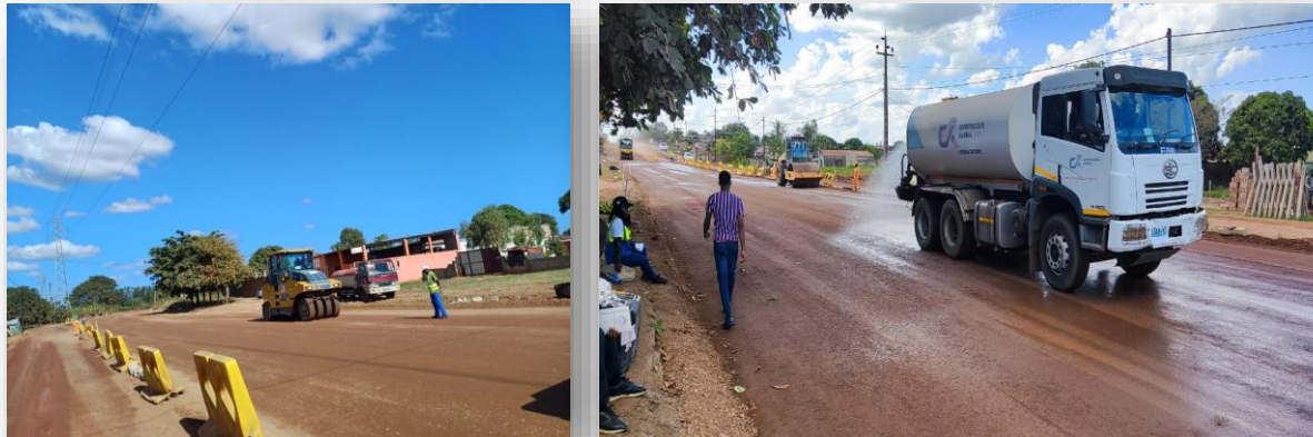
Figura 10 – Construção na Estrada N200 / Figure 10 – Construction on the N200 Road
