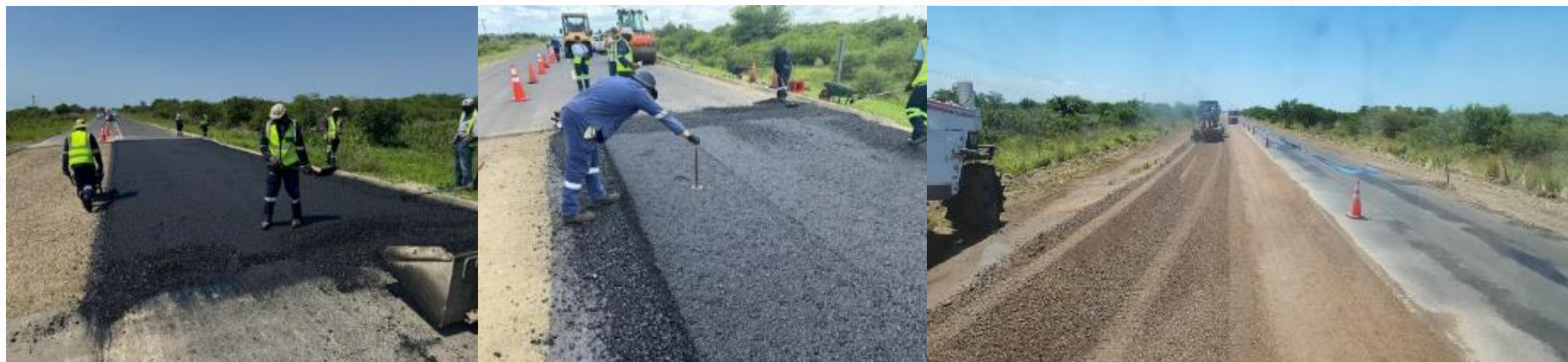
Figura 17 – Manutenção Periódica na Estrada de Ligação / Figure 17– Routine Maintenance on the Connecting Road
