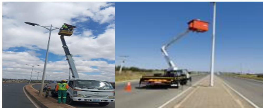
Figura 20 – Reposição de Luminárias: N6 - Cidade de Chimoio/ figure 20 – Replacement of Street Lighting: N6 - Chimoio City
