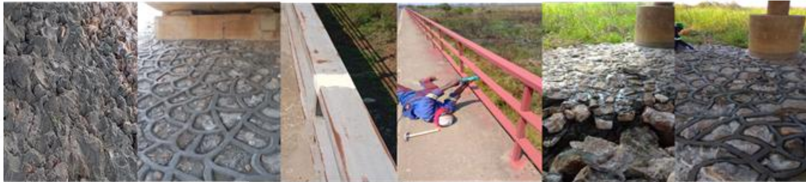
Figura 30 – Reparação e manutenção de 3 pontes na Baixa do Pungué e 3 pontes em Manica (Chiraidze, Inhamatanda e Chibamdina) / Figure 30 - Repair and Maintenance of 3 Bridges in Baixa do Pungué and 3 Bridges in Manica (Chiraidze, Inhamatanda, and Chibamdina)
