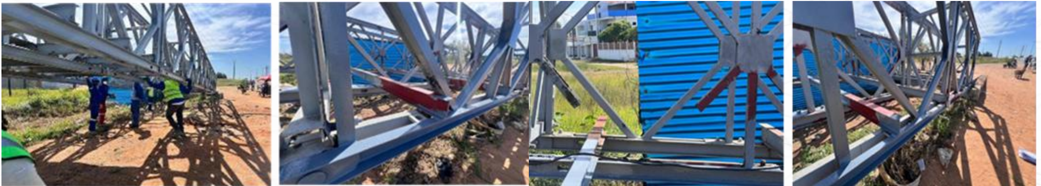
Figura 21 – Reparação da Ponte Pedonal de Chiango / Figure 21- Repair of the Chiango Pedestrian Bridge
