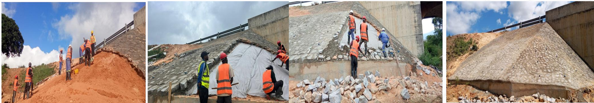
Figura 28– Reparação e Manutenção de 5 Passadeiras Aéreas em, Sofala (Munhava, Vaz, JJ, Mobeira e Dondo)/ Figure 28 - Repair and Maintenance of 5 Overhead Conveyor Belts in Sofala (Munhava, Vaz, JJ, Mobeira, and Dondo)
