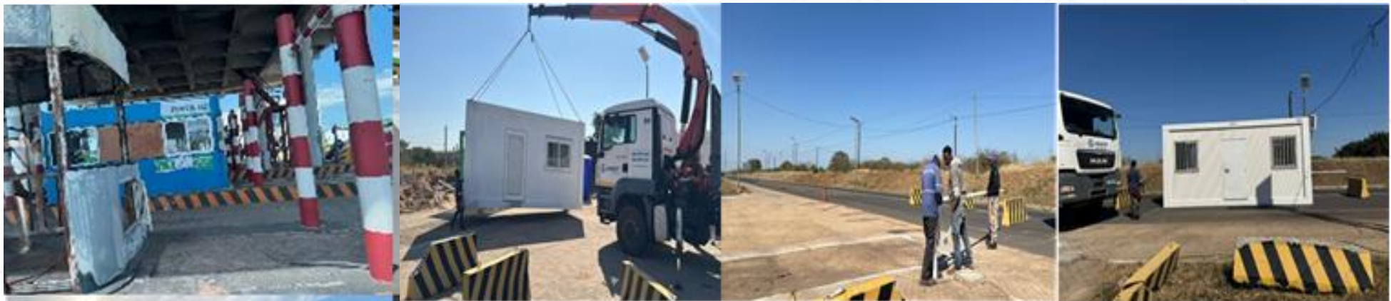
Figura 18 – Reabilitação da Portagens da Circular de Maputo e Estrada de Ligação / Figure 18 – Rehabilitation of the Maputo Ring Road and Link Roads Toll Plazas
