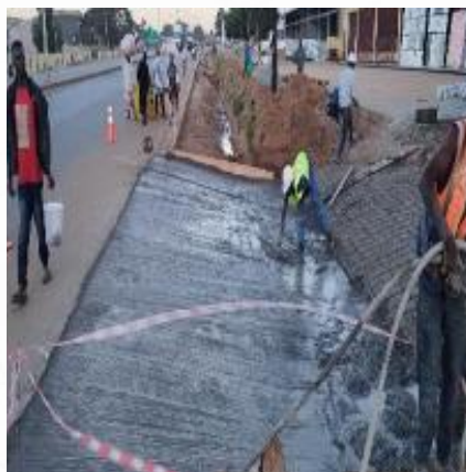
Figura 29 – Obras de Drenagem Mista no km 87+600, em Manica / Figure 29 - Drainage works at km 87+600 in Manica
