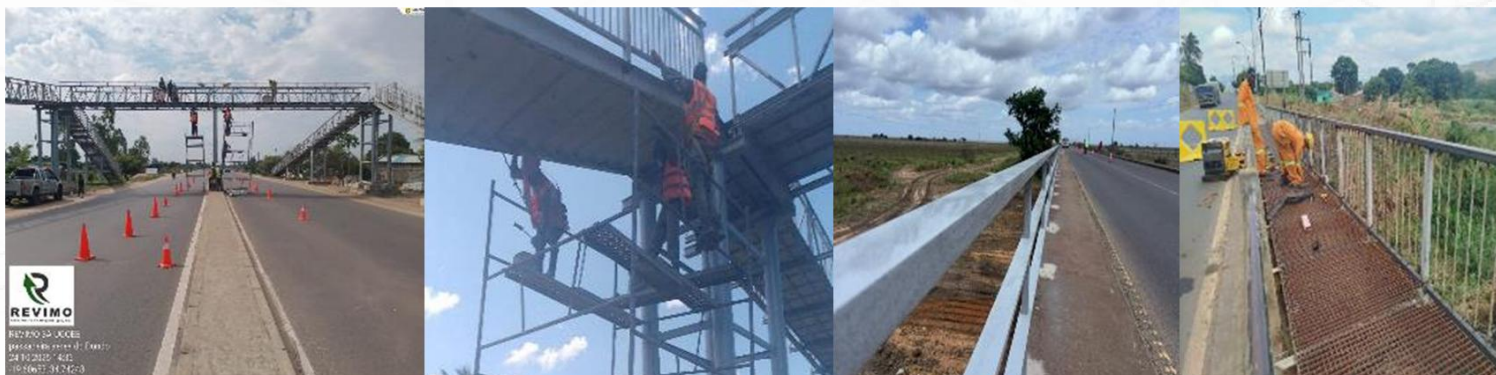
Figura 27 – Reparação e Manutenção de 5 Passadeiras Aéreas em, Sofala (Munhava, Vaz, JJ, Mobeira e Dondo) / Figure 27 - Repair and Maintenance of 5 Overhead Conveyor Belts in Sofala (Munhava, Vaz, JJ, Mobeira, and Dondo)
