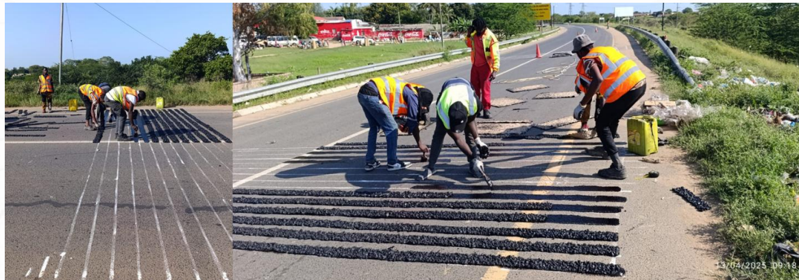
Figura 19 – Instalação de Lombas, bandas sonoras e sinalização horizontal na vila de Salamanga - Província de Maputo / Figure 19 – Installation of Speed Humps, Rumble Strips and Road Markings in Salamanga, Maputo Province
