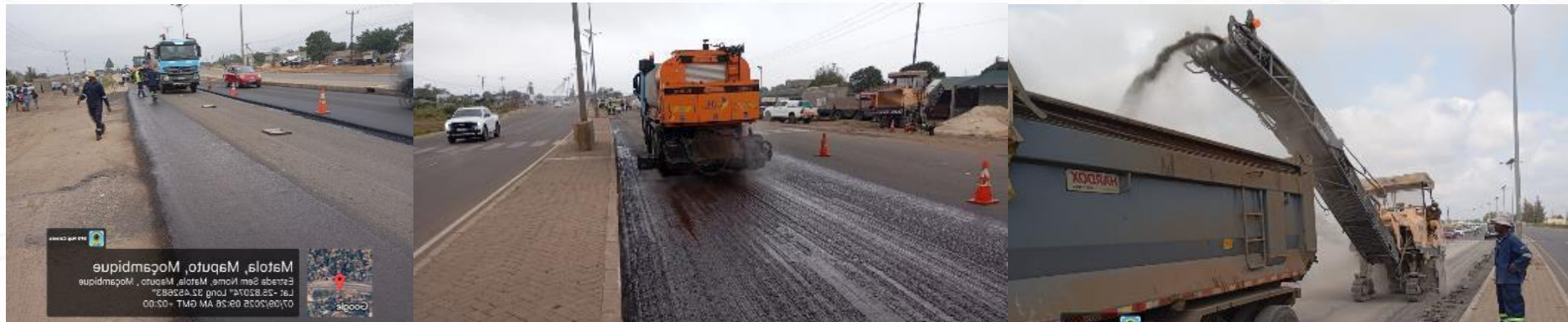
Figura 20 – Manutenção Periódica na N204 / figure 20 – Periodic Maintenance on N204
