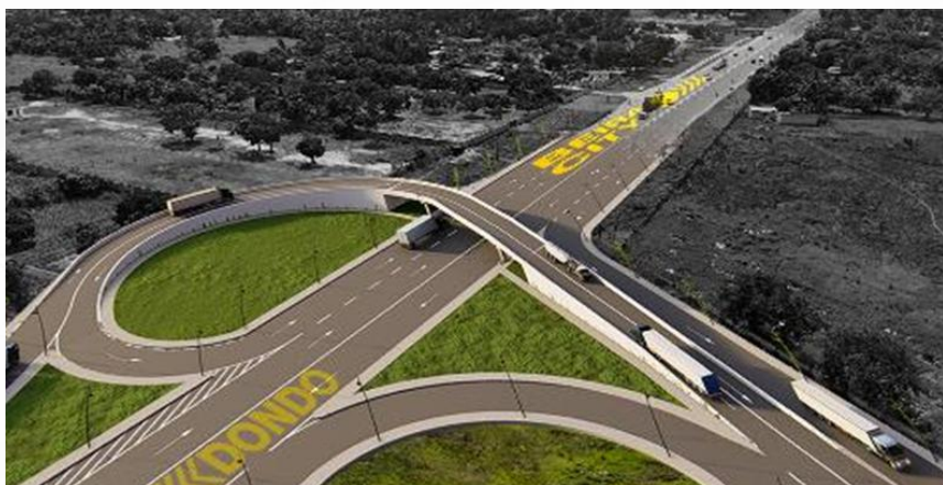
Figura 6 – Nó de Ligação ao Porto da Beira na estrada N6/ Figure 6 – Interchange on the N6 Highway to Port of Beira
