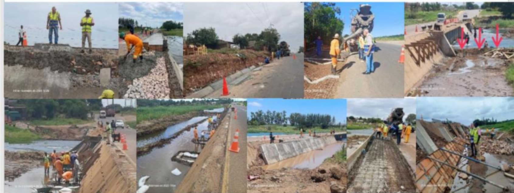
Figura 16 – Conclusão da construção na Estrada N200 / Figure 16 – Construction on the N200 Road
